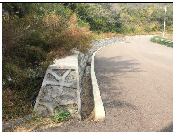
浆砌石挡墙、混凝土排水沟、排水管
